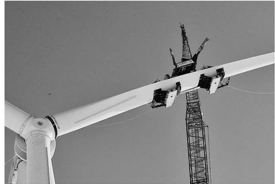
Mit seinen RBC-D-Traversen hat ematec laut eigener Aussage die Montage von Rotorblättern revolutioniert. FOTO: JULIAN EBERHARD/EMATEC
