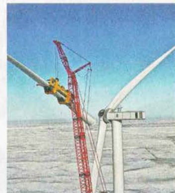
Auf der ganzen Welt kommen die Greifwerkzeuge von Ematec bei der Montage von Rotorblättern an Windkraftanlagen zum Einsatz. Foto: Ematec
