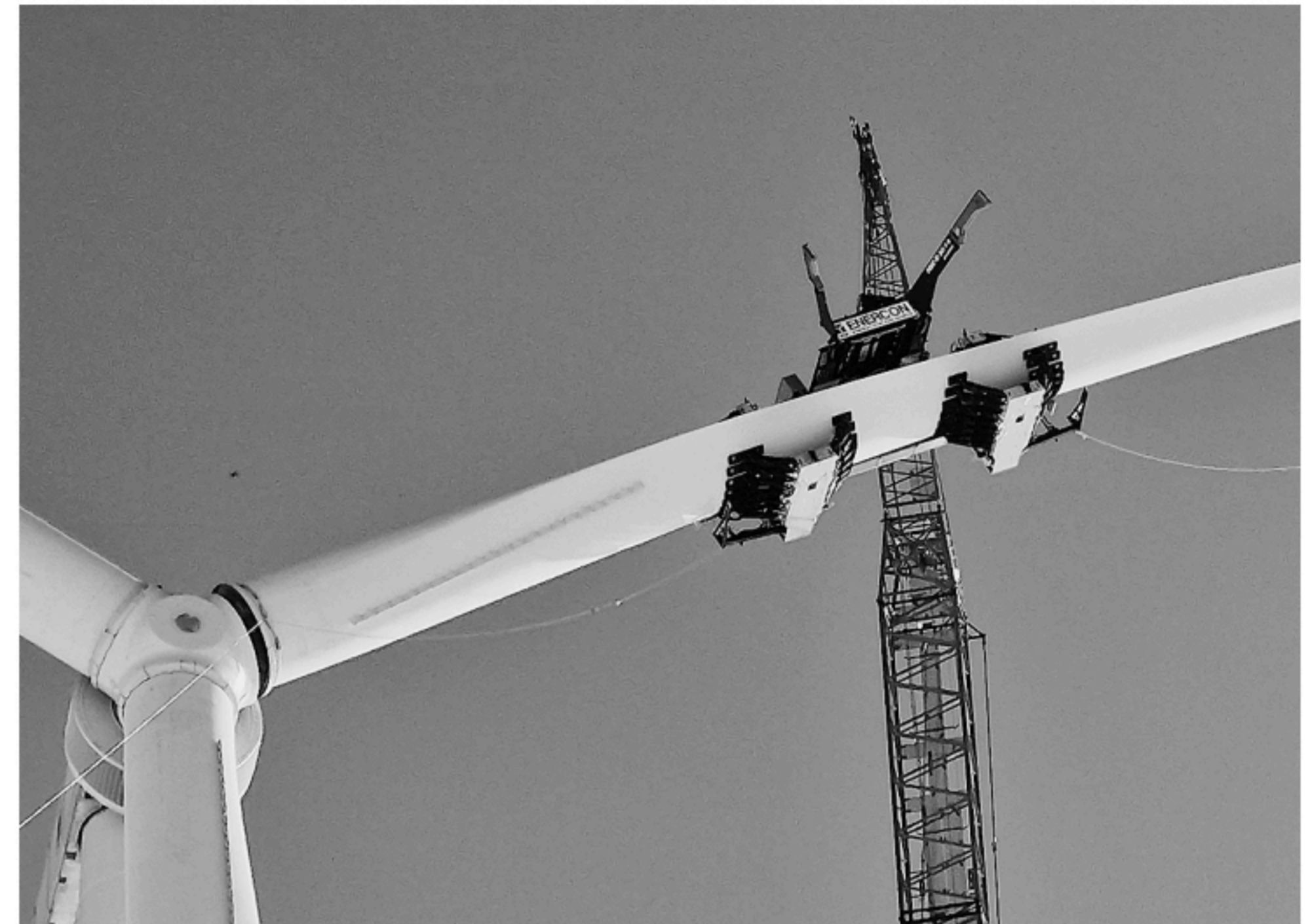
Mit seinen RBC-D-Traversen hat ematec laut eigener Aussage die Montage von Rotorblättern revolutioniert. FOTO: JULIAN EBERHARD/EMATEC
