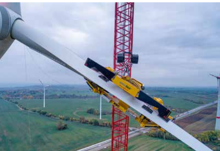
Die RBC-Traverse kann alle Flügelformen handeln.
