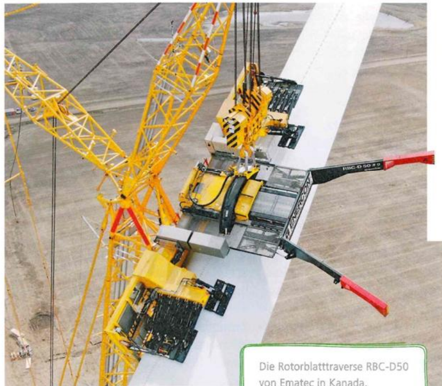
Der Windkraftanlagenhersteller Enercon setzt auf die Traversen der RBC-Reihe. Fotos: Ematec/Ingo Jensen/Julian Eberhard/Hans-Martin Pfeifer
