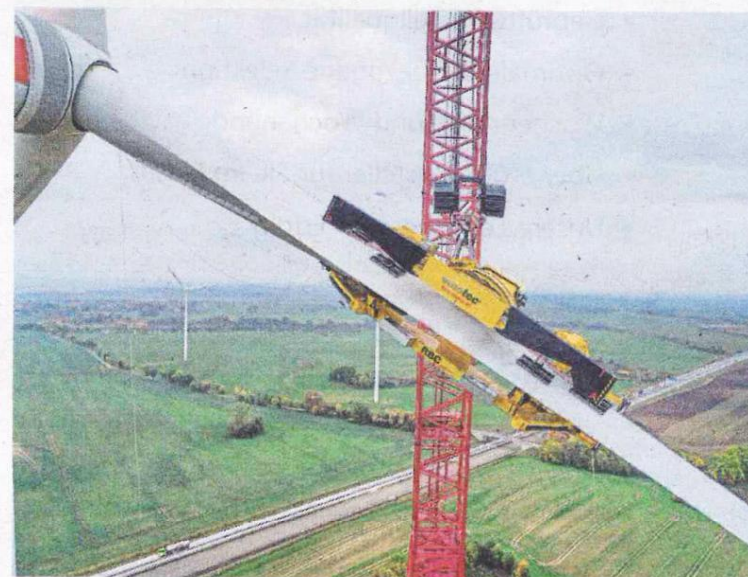
Kann alle Flügelformen am Markt aufnehmen und handeln: Die RBC-Traverse von ematec.
