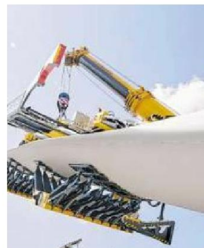
Eine Rotorblatt-Traverse von ematec im Einsatz bei der Montage einer Windkraftanlage. Foto: Ingo Jensen
