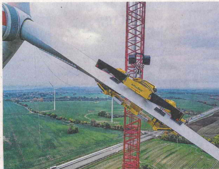
In luftiger Höhe montiert Ematec Rotorblätter an Windkraftanlagen. Foto: Ematec
