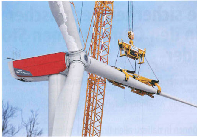
Höchste Arbeits- und Funktionssicherheit bietet die neue Rotorblatttraverse. Bild: Ematec
