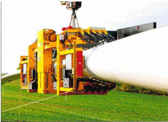
Links : In perfekter Balance: Über zwei Gegengewichte an den Traversenflügeln findet die RBC immer exakt den richtigen Schwerpunkt. Rechts : Neigungswinkel von \pm 30 Grad – für die RBC-Traversen von ematec kein Problem. Die Photos wurden im August 2020 am Lagerweg-Prototypen in Wieringermeer, Niederlande, aufgenommen.
