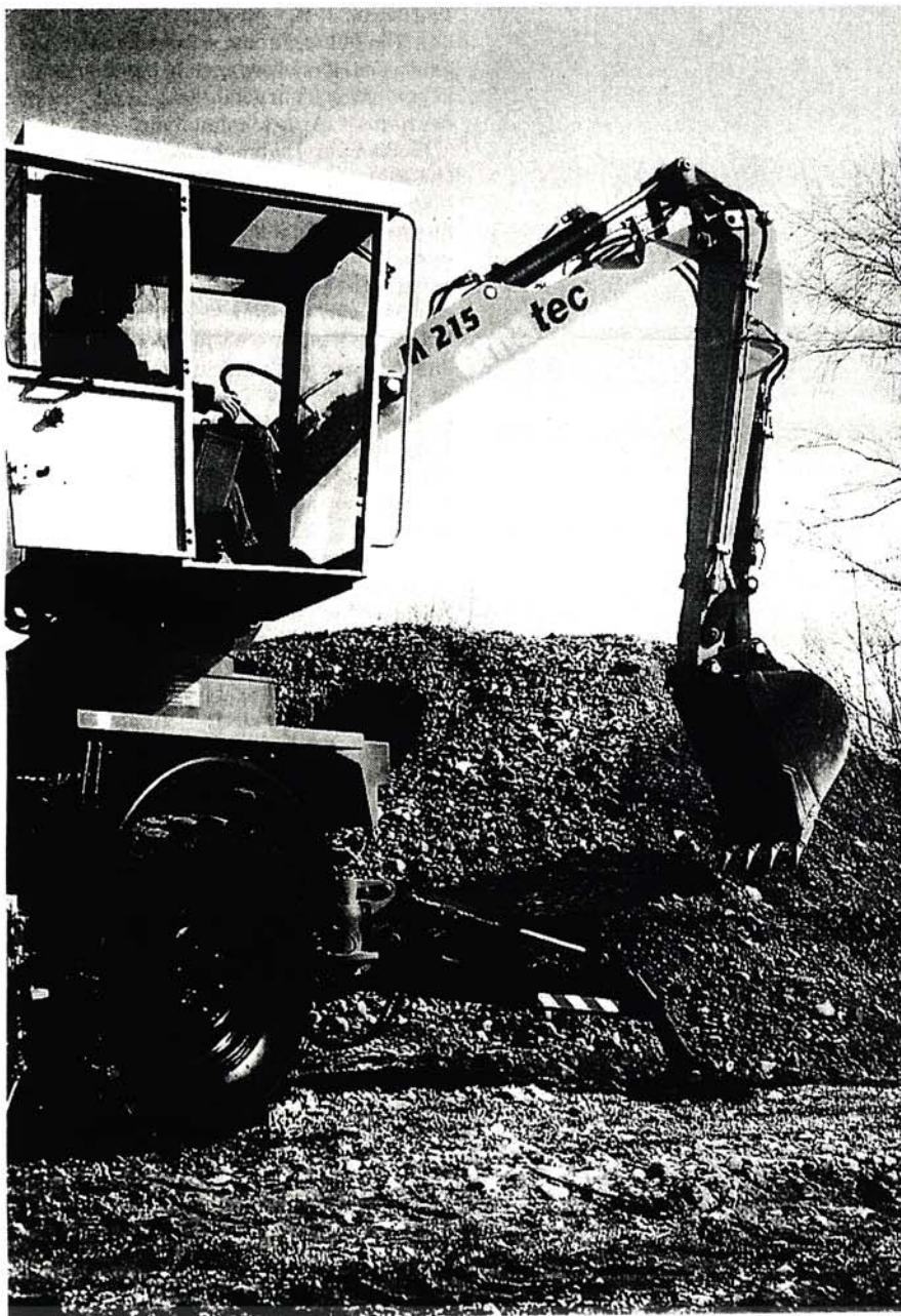
Der Führerstand ist nicht hinter, sondern neben dem Baggerstiel.
