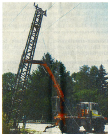
Problemloses Vorbereiten und Aufstellen von Masten im Freileitungsbau Foto: ematec
